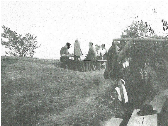
Erste Arbeiten und Raststellen auf dem Berg
